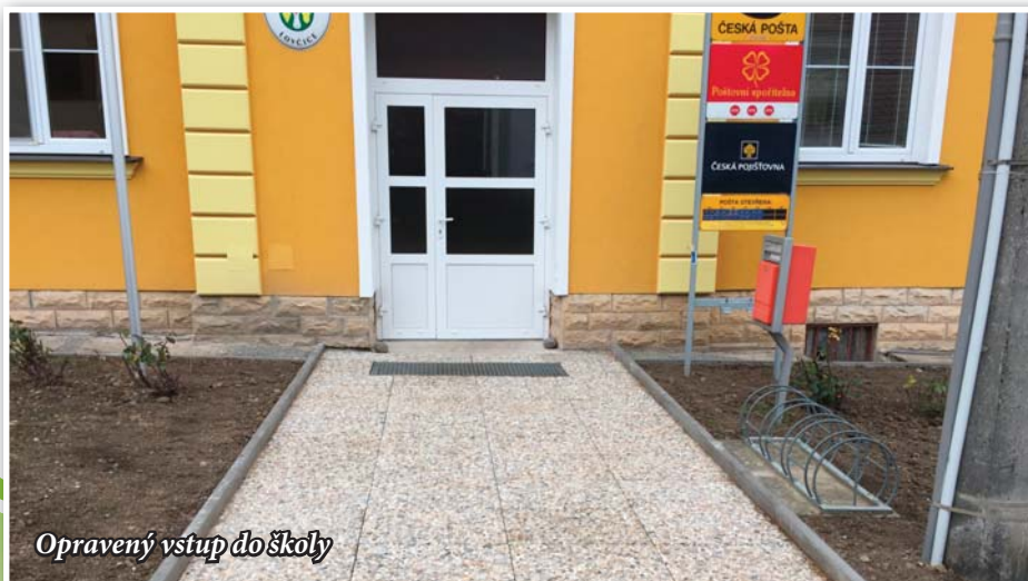
Nová střecha a fasáda na tělocvičně MŠ a ZŠ, chodníčky na školní zahradě
