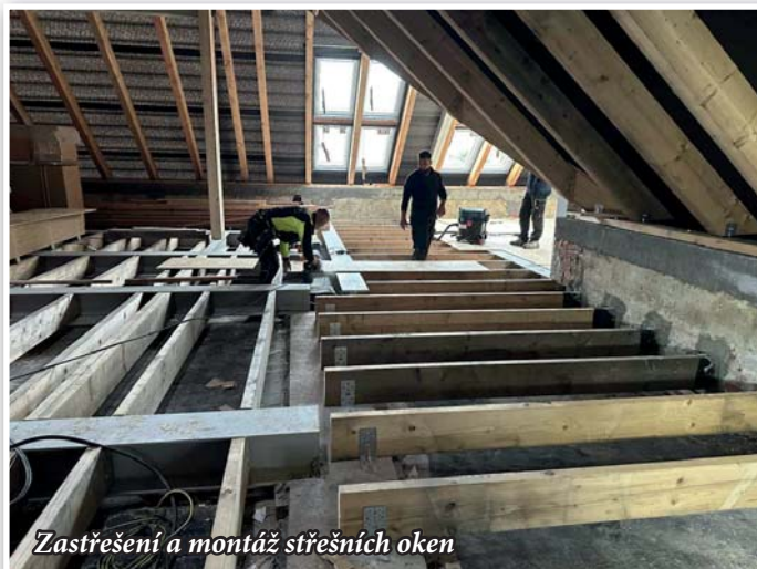
Nová podlaha zpevněná železnými nosníky
